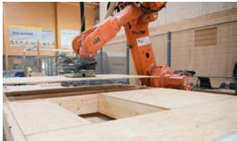
Abbildung 8: Umgesetzte Roboterprogrammierung für die Verlegung der Grobspanplatten eines Wandelementes
